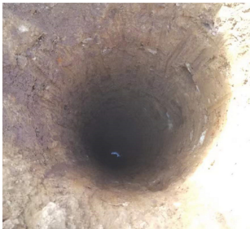
图 1 回填黏土后挤压的孔壁
