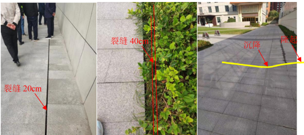
图 4 基坑西侧地面开裂照片
